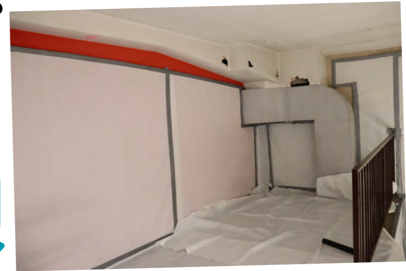
Pose de protections pour le désamiantage.
