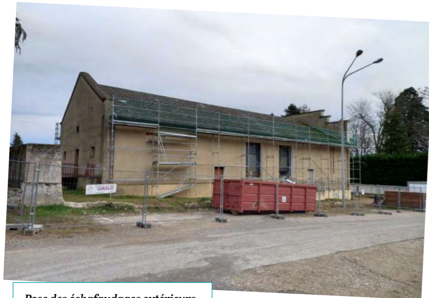
Pose des échafaudages extérieurs.
