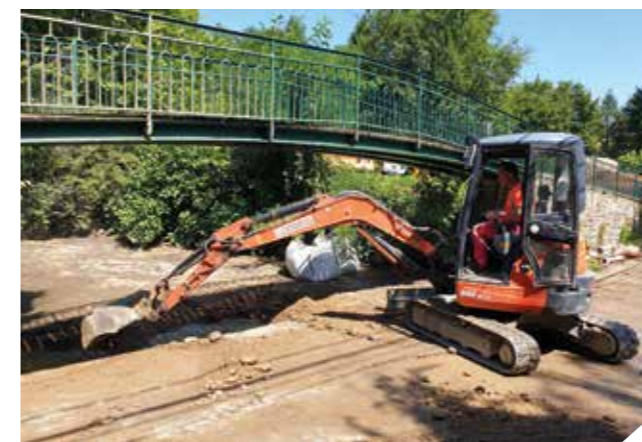
Déviation de réseaux à Francheville
