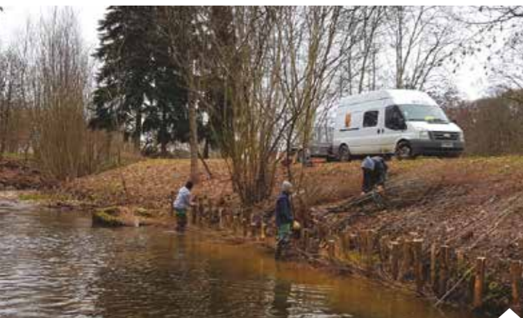
Pose de fascines de saules pour renforcer les berges de l'Yzeron à Brindas
