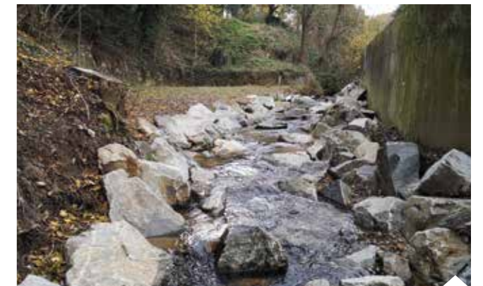
La rampe en enrochement à 4% de pente a été réalisée en lieu et place d'une maison en ruine qui constituait un obstacle infranchissable pour la remontée des poissons
